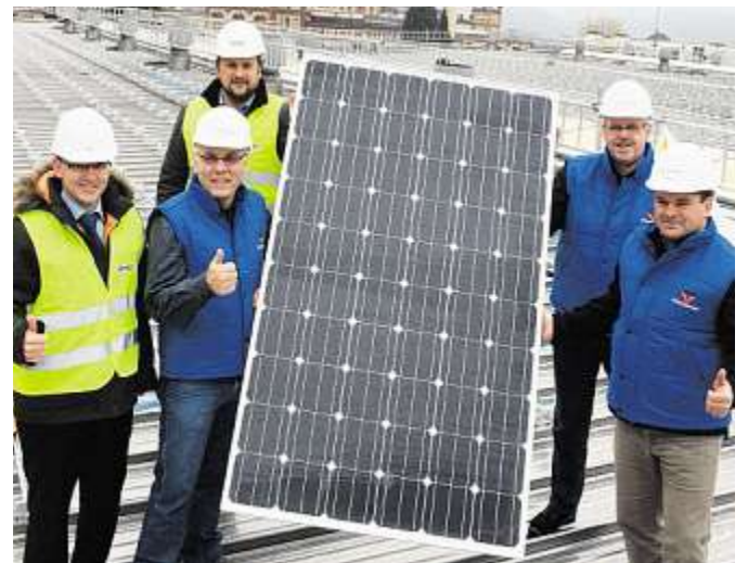
Vertreter der Kleinkraftwerk Birseck AG (Investor und Betreiber), Tritec (Hersteller) und Feldschlösschen beim Baustart der Anlage.
